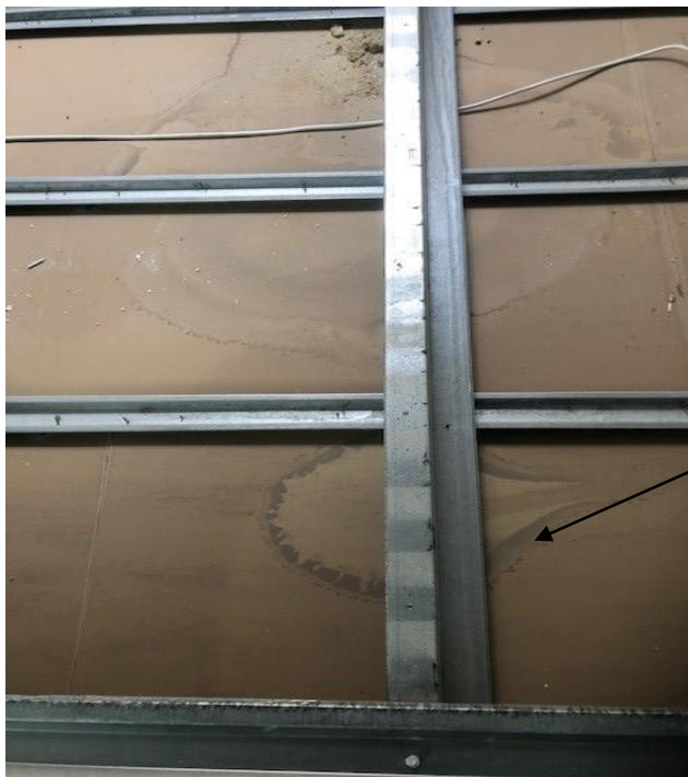
Bild 8: Bild över gipsskiva med fläckar från vattenskadan 2018. Mikrobiell analys 177-2020-09150863 visar normala värden bakterier men något förhöjda värden svampar.
