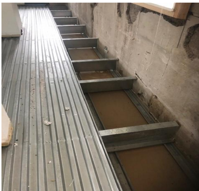
Bild 5: Vid rivning - Golvbjälklag och yttervägg mot takterrassen efter demontering av väggens mineralullsisolering.
