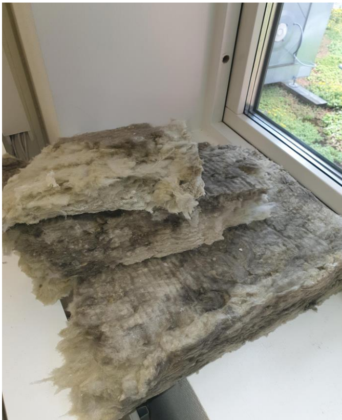
Bild 3: Vid rivning - Demonterad mineralullsisolering.
