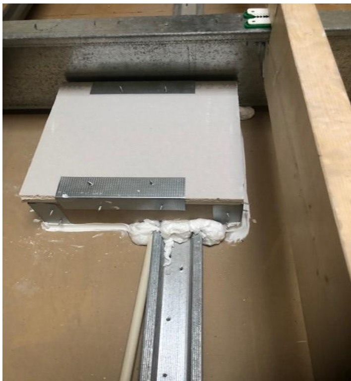
Bild 7: Efter åtgärd - Brandklassad gipslåda ovan downlights i gipsundertak.
