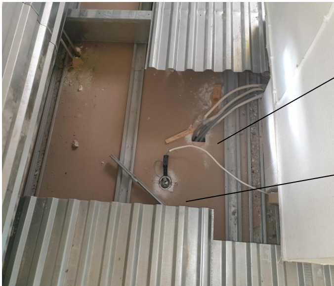
Bild 7: Genomföringar i gipsskiva under den bärande bjälklagskonstruktionen.
