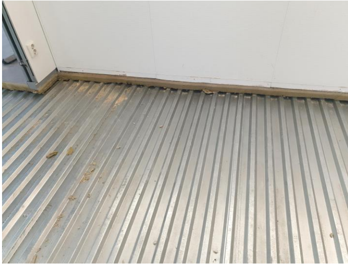
Bild 6: Vid rivning - Bärande bjälklagskonstruktion – efter demontering av golvisolering samt golvspånskivor.
