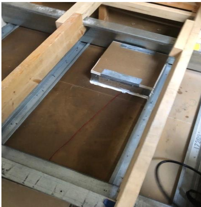
Bild 9: Efter åtgärd - Ovansida gipsundertak efter rengöring och behandling med Jape Mögel-fri.
