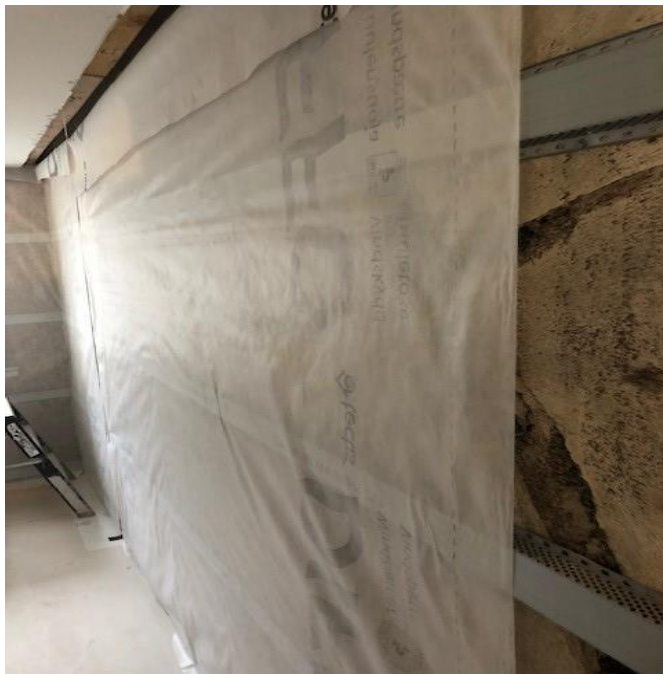
Bild 4: Under uppbyggnad – Ytterväggen är efter åtgärd, ventilerad.
