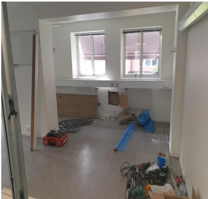
Bild 1: Vid rivning - Översiktsbild – kontor innan renovering.
